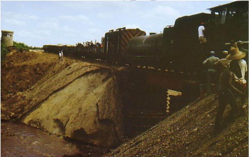
Die Brücke ist in stand gesetzt
