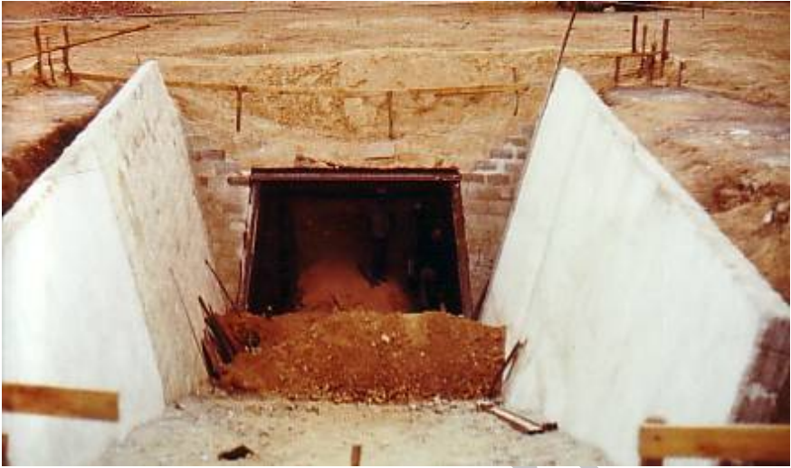
Chipanga XI: Schräge Stützmauern stehen da
