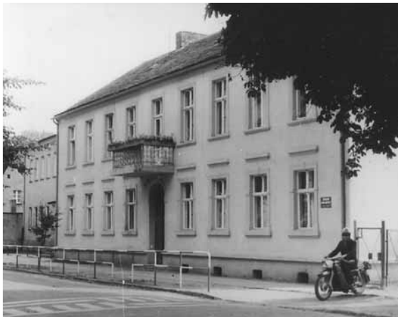
Else's Wohnhaus in der Gartenstraße 6
