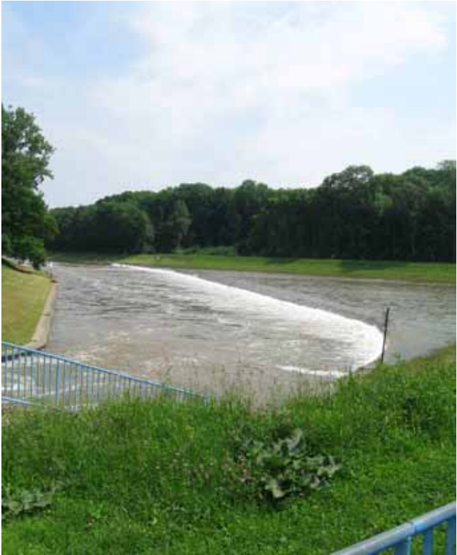
Am Teilungswehr in Großschocher Juni 2013 Elsterflutkanal links, Hochflutbett (Oberes Elsterflutbett) rechts
