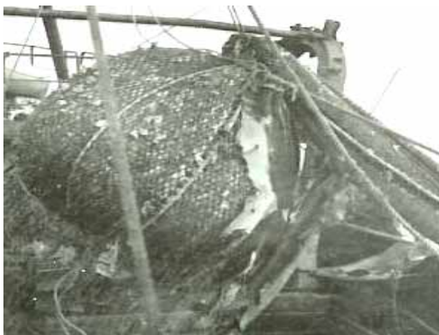
Der Steert wird über das Schanzkleid gehievt.
