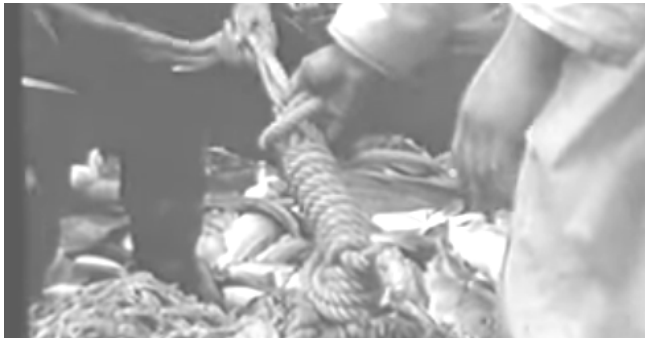
Der Zweite Steuermann fertigt den Steertknoten.
